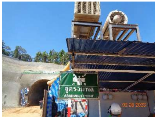
รูปที่ 2-86 ระบบระบายอากาศชั่วคราว
