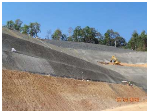
รูปที่ 2-78 กิจกรรมการติดตั้งโครงสร้างป้องกันการชะล้างพังทลายของดินบริเวณปากอุโมงค์ช่วงที่ 2 จังหวัดพะเยา
