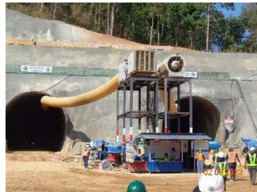
รูปที่ 2-86 ระบบระบายอากาศชั่วคราว
