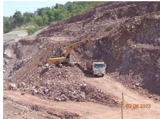
รูปที่ 2-77 กิจกรรมงานขุดดินเพื่อปรับระดับ Excavation general /Slope Protection บริเวณพื้นที่อุโมงค์ช่วงที่ 2 (ทิศใต้) จังหวัดพะเยา
