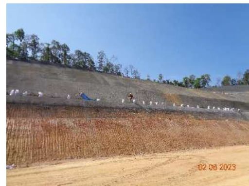
รูปที่ 2-78 กิจกรรมการติดตั้งโครงสร้างป้องกันการชะล้างพังทลายของดินบริเวณปากอุโมงค์ช่วงที่ 2 จังหวัดพะเยา
