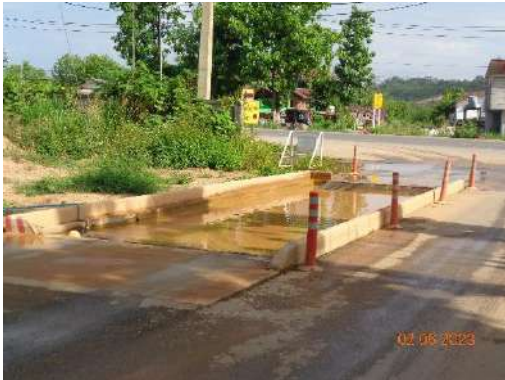
รูปที่ 2-42 บ่อล้างล้อรถ บริเวณทางเข้าบ้านพักคนงาน
